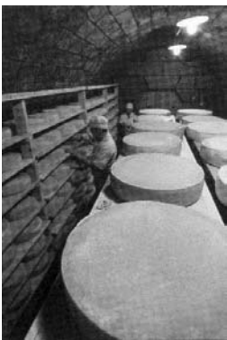
自然のエネルギーを活かす札幌軟石を組んで造った地下のチーズ熟成室
